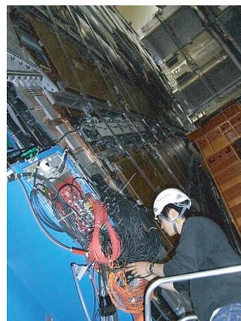
図 5.16: UX15 での HSC クレータのケーブリング
