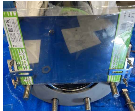
図 2.5: スペーサーを使用しているところ
