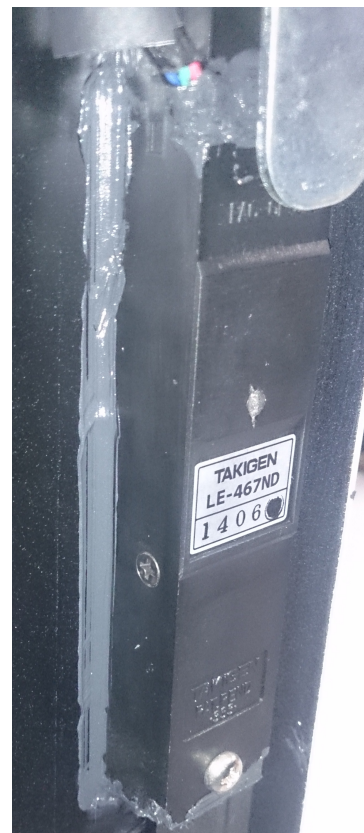
図 3.14 ドア取っ手部の裏側をパテで埋めた様子。上面、前面のドアともに同様の処置が施されている。図は前面のドア。
